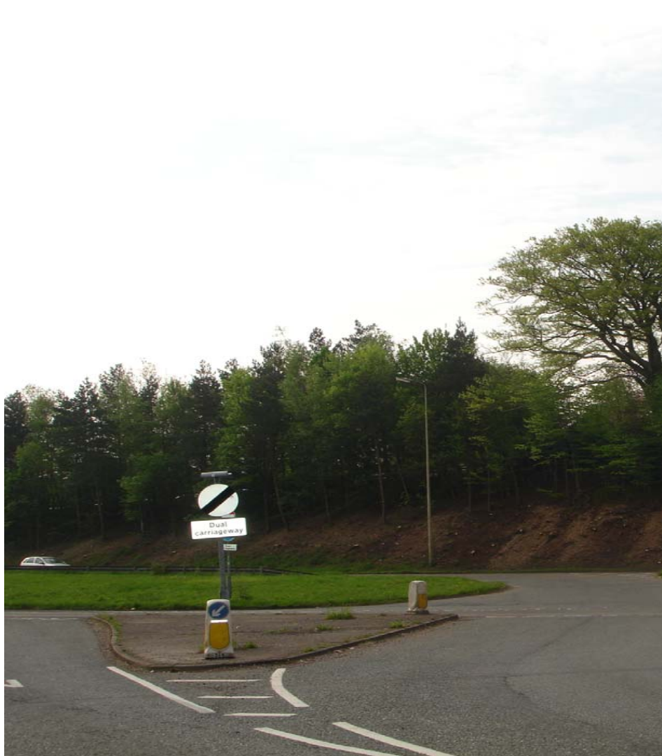
Site Number 23 (RIS) Blythe Bridge Updated Site
